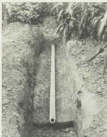
Abb. 3: Maschinengeformter Rohrstrang in situ.
